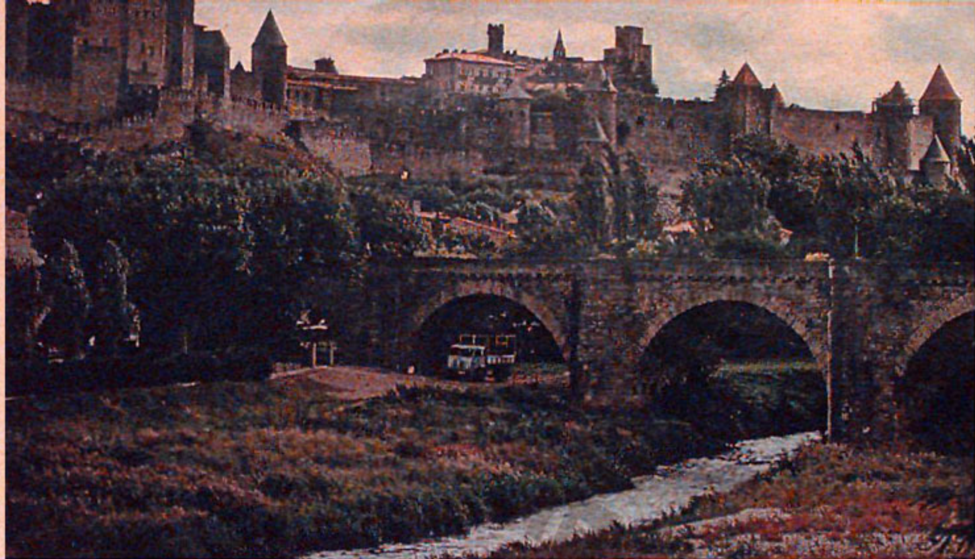
Este puente da acceso a la ciudad a través de la Puerta Narbonesa. Sobre él, las sucesivas zonas amuralladas de Carcasona.
